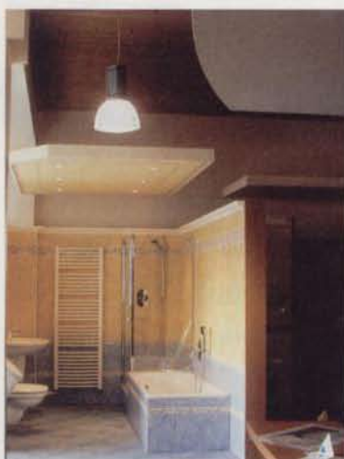
Ausstellungsraum des Bauherrn im Erdgeschoss. Die Planerin setzte auf eine Brettstapeldecke
