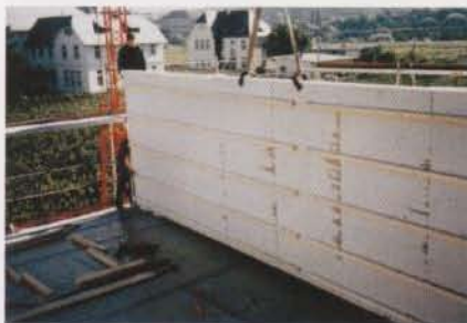
Bild 7: Montage einer vorgefertigten Wohnungstrennwand.
