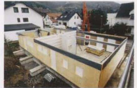
Bild 8: Erdgeschoß mit Wohnungstrennwand und Stahlunterzügen vor der Verlegung der Deckenelemente.
