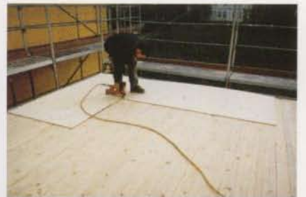
Bild 10: Im Bereich der Deckenränder wurden umlaufend BFU-Platten auf die Deckenelemente genagelt, um die Scheibenwirkung der Decken zu unterstützen.
