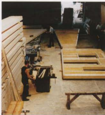
Bild 6: Vorfertigung der Wandelemente in der Zimmerei
