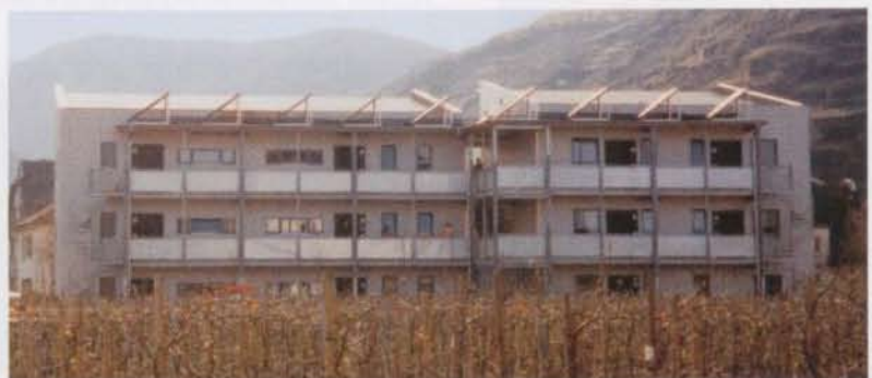
Bild 2: Nordostseite des 9-Familienhauses mit Laubengang und Solaranlage
