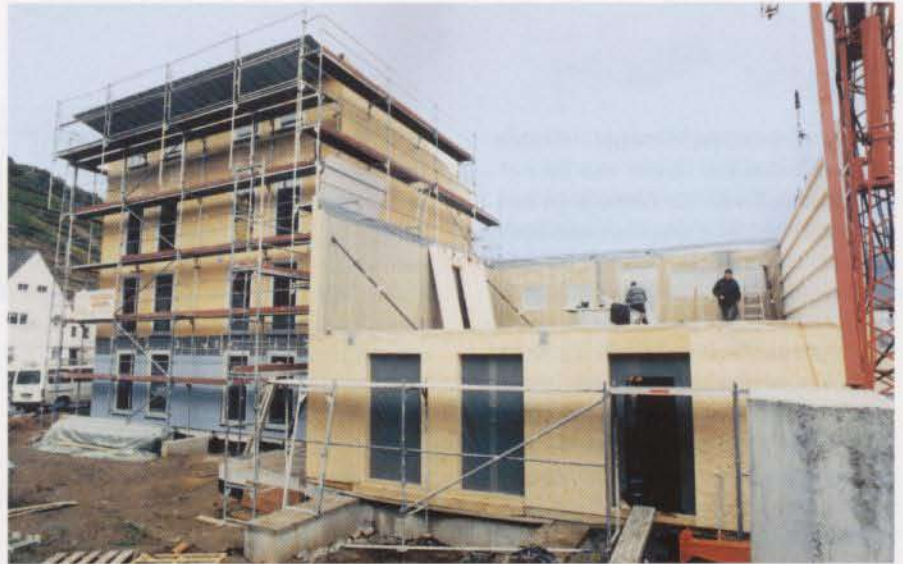
Bild 11: Nach 5 Tagen war der erste Bauabschnitt montiert.
