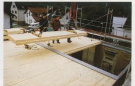
Bild 9: Einbau von Deckenelementen
